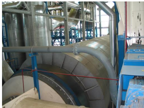
Сушка осадка, Мадрид (барабанная сушка)
