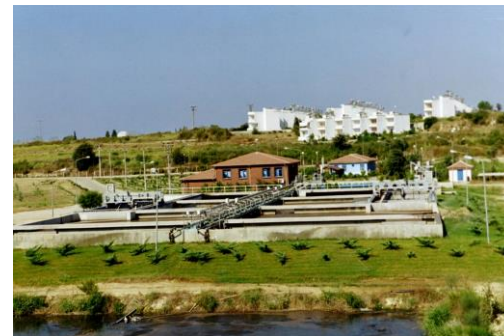
Внешняя аэробная стабилизация осадка Чолаклы, Турция
