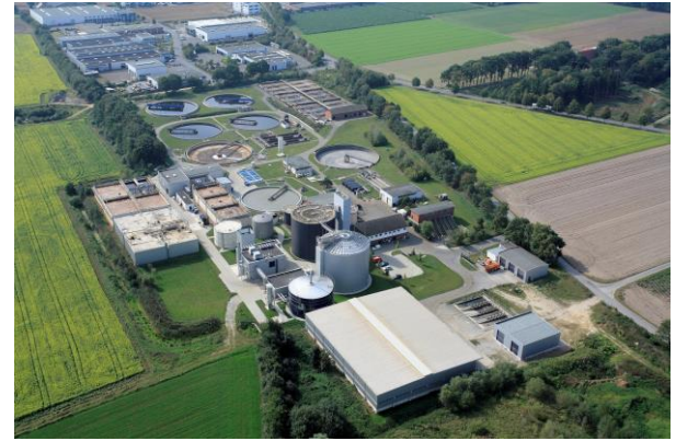
Коферментация отходов со скотобоев (производство энергии 3 МВт эл )
