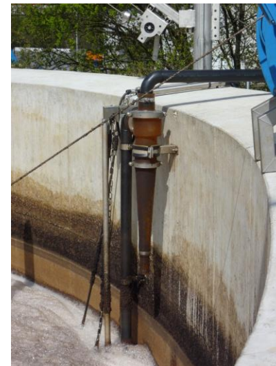
Сепарация анаммокс-бактерий с помощью гидроциклона
